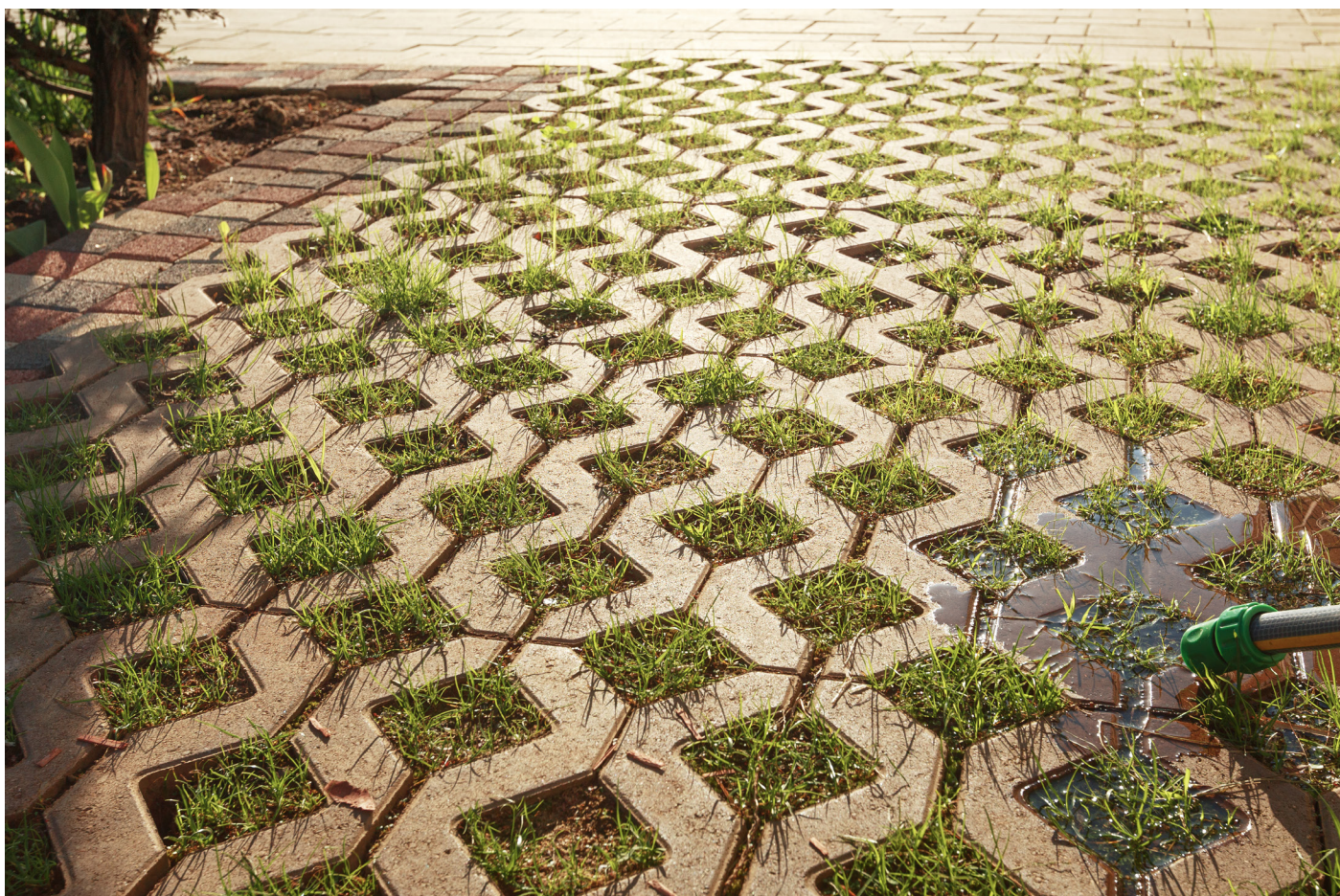
Genomsläpplig beläggning av betong med gräsbevuxna håligheter.
