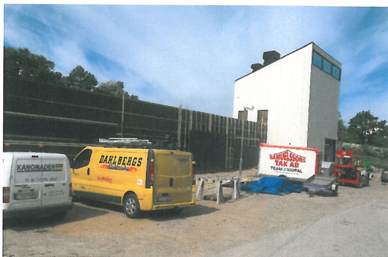
Avloppsreningsverket från entrésidan
