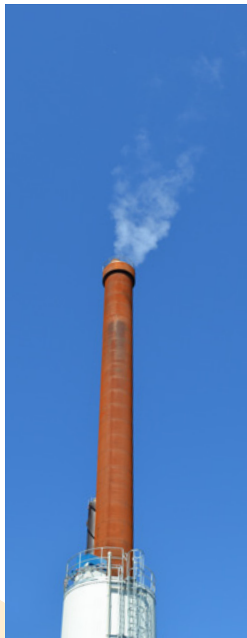
SKORSTENEN TILL PANNA 5
