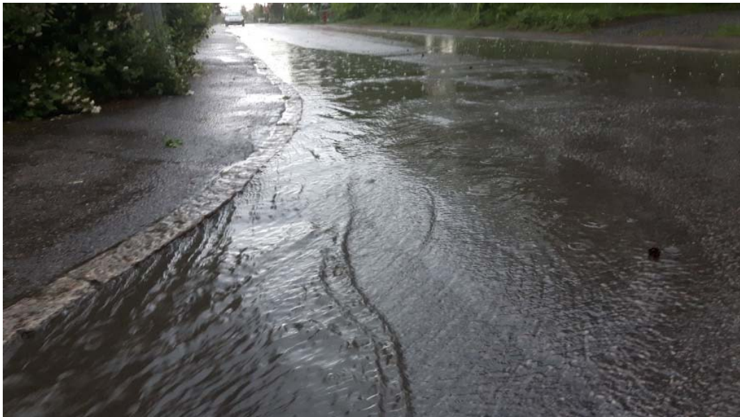
Bild 1. Yttlig avrinning vid kraftigt regn.
